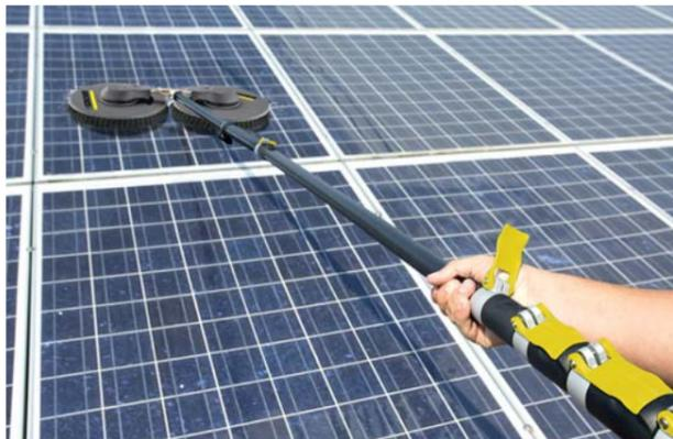
使用例 ▶ 太陽電池モジュールの洗浄
