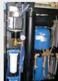
Úprava vody řízená údaji z čidel
