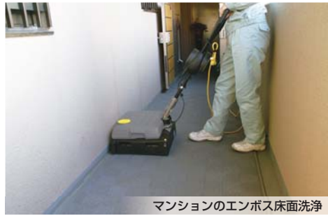
マンションのエンボス床面洗浄
