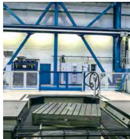
Ausgelagerte Saugstelle für großflächige Zerspanungsplätze
