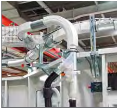
● Potrubní systém s elektropneumatickou klapkou a elektrickými řídicími jednotkami
