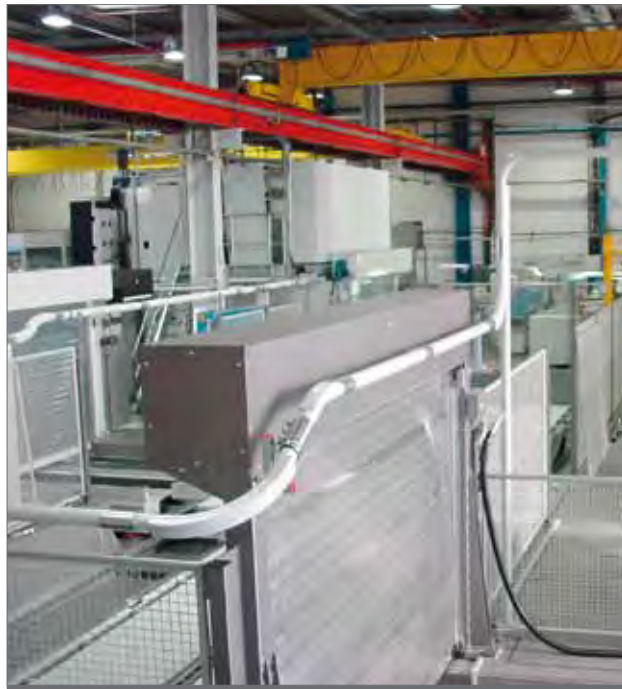
● Vysávací místo s výkyvným ramenem a potrubním vedením
