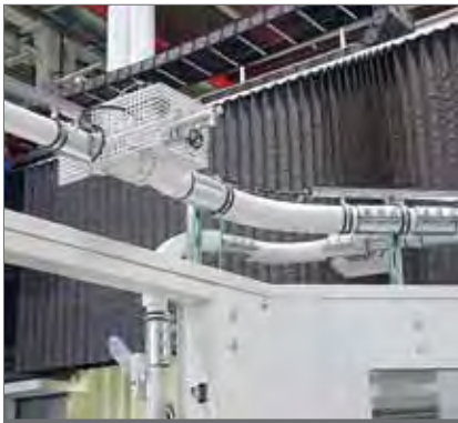
● Potrubní systém s elektropneumatickou klapkou a elektrickými řídicími jednotkami
