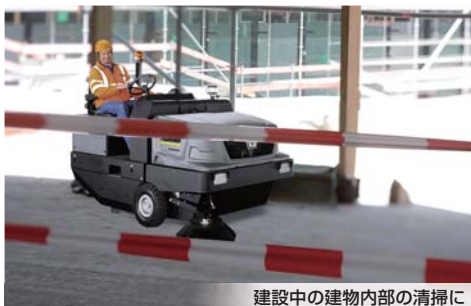
建設中の建物内部の清掃に
