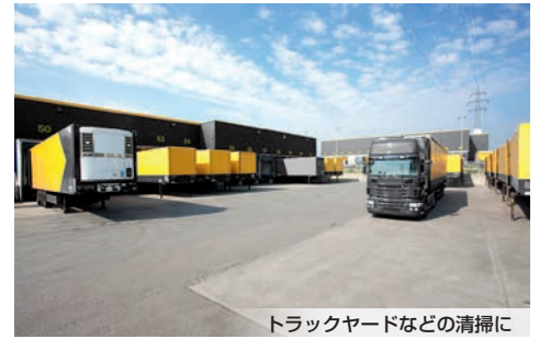
トラックヤードなどの清掃に
