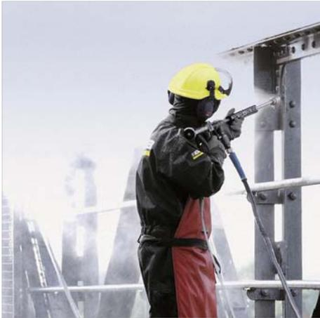
建設現場の鉄骨塗膜の剥離処理
