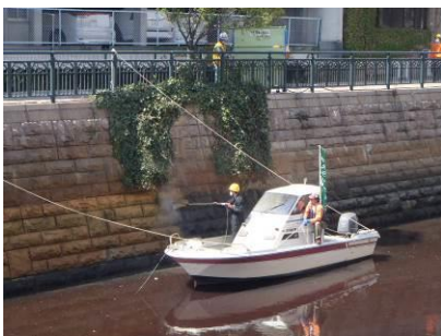
洗浄作業の様子 4/15(火)
