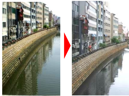
洗浄前・後 護岸の黒ずみを洗浄で取り除きました
